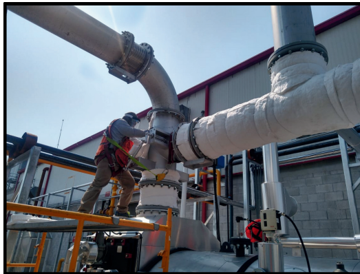
AISLAMIENTO DE TUBERÍAS
