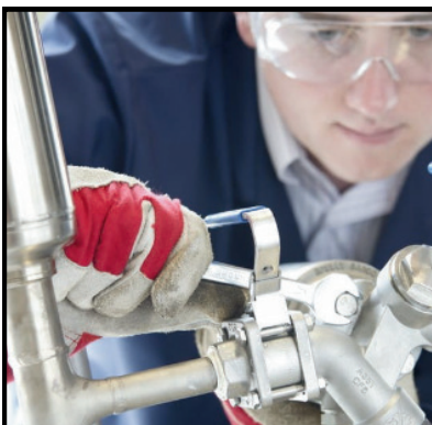
MANTENIMIENTO DE TRAMPAS DE VAPOR
