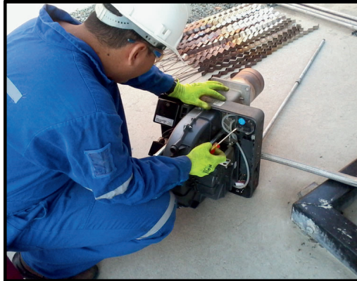
MANTENIMIENTO DE QUEMADORES
